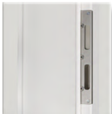
verstärktes Schließblech mit Stahlhalteplatte Nr. 35 Ansicht Futterbrett
